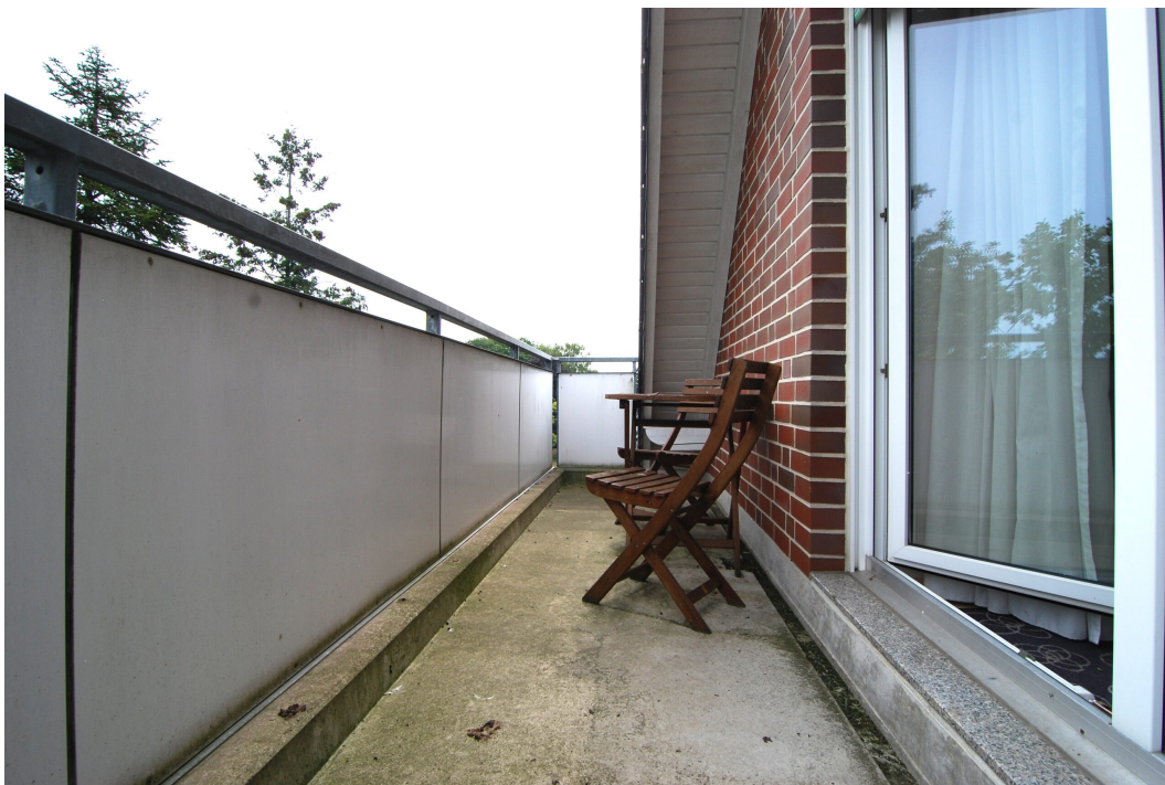
Waldstrasse24 DGrechts Balkon 1
