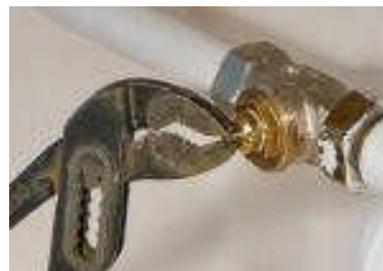
Der Stift sollte etwas herausstehen und sich mit wenig Kraft hineindrücken lassen. Wenn nicht, den Stift mit der Zange vorsichtig kurz nach vorne ziehen (ca. 3-5mm). Alternativ kann man auch mit leichten Schlägen auf den Stift versuchen, ihn zu lösen (z.B. mit dem Griff eines Schraubenziehers).
