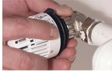
... Thermostatkopf vorsichtig mit der Zange nach rechts anziehen (im Uhrzeigersinn)
