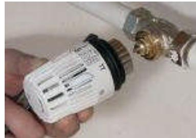
... der Stift, der dann sichtbar wird, regelt die Zufuhr des Heizwassers. Wird es im Raum kälter, als am Thermostatkopf eingestellt, drückt der Thermostat den Stift hinein und öffnet damit den Zustrom warmen Wassers.
