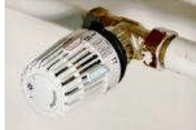
... mit der Rohrzange die Überwurfmutter links herum lösen (gegen den Uhrzeigersinn)
