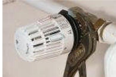
Manchmal reicht es aus, anstelle des Abschraubens des Thermostatkopfes mit einem festen Gegenstand (kleiner Hammer) kurz von unten gegen die Rohrleitung zu schlagen. Aber bitte nur gegen das Rohr und nicht gegen das Ventil bzw. den Thermostatkopf! Sollte sich nach max. zwei bis drei Schlägen der Stift noch nicht gelöst haben, hilft nur das Schrauben ... (Zur Illustration wurde bei dem Foto der Thermostatkopf vorher abgeschraubt)
